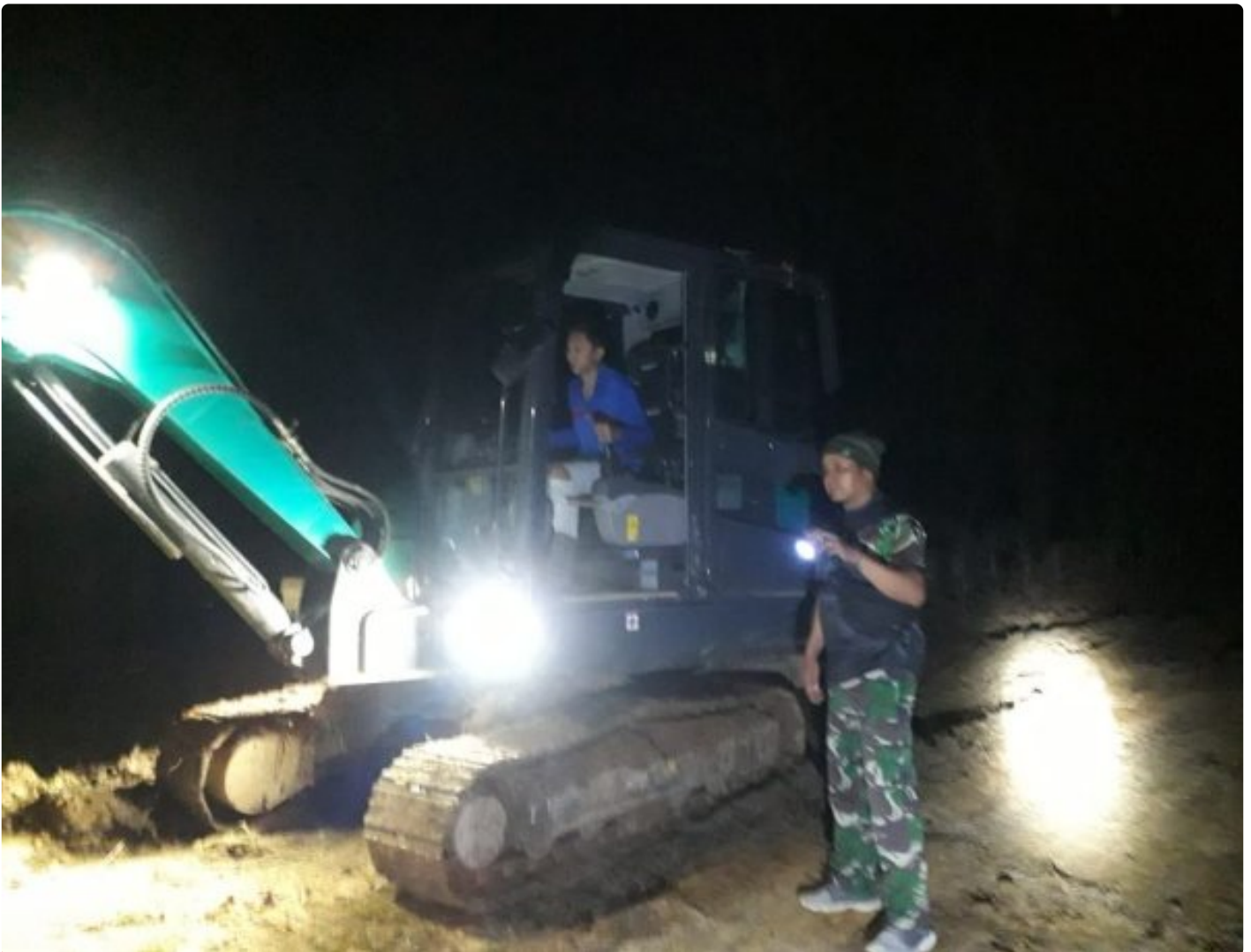
Jelang Akhir, Satgas TMMMD Ke 116 Kodim 1004/Kotabaru Terus Kebut Sasaran Jalan
