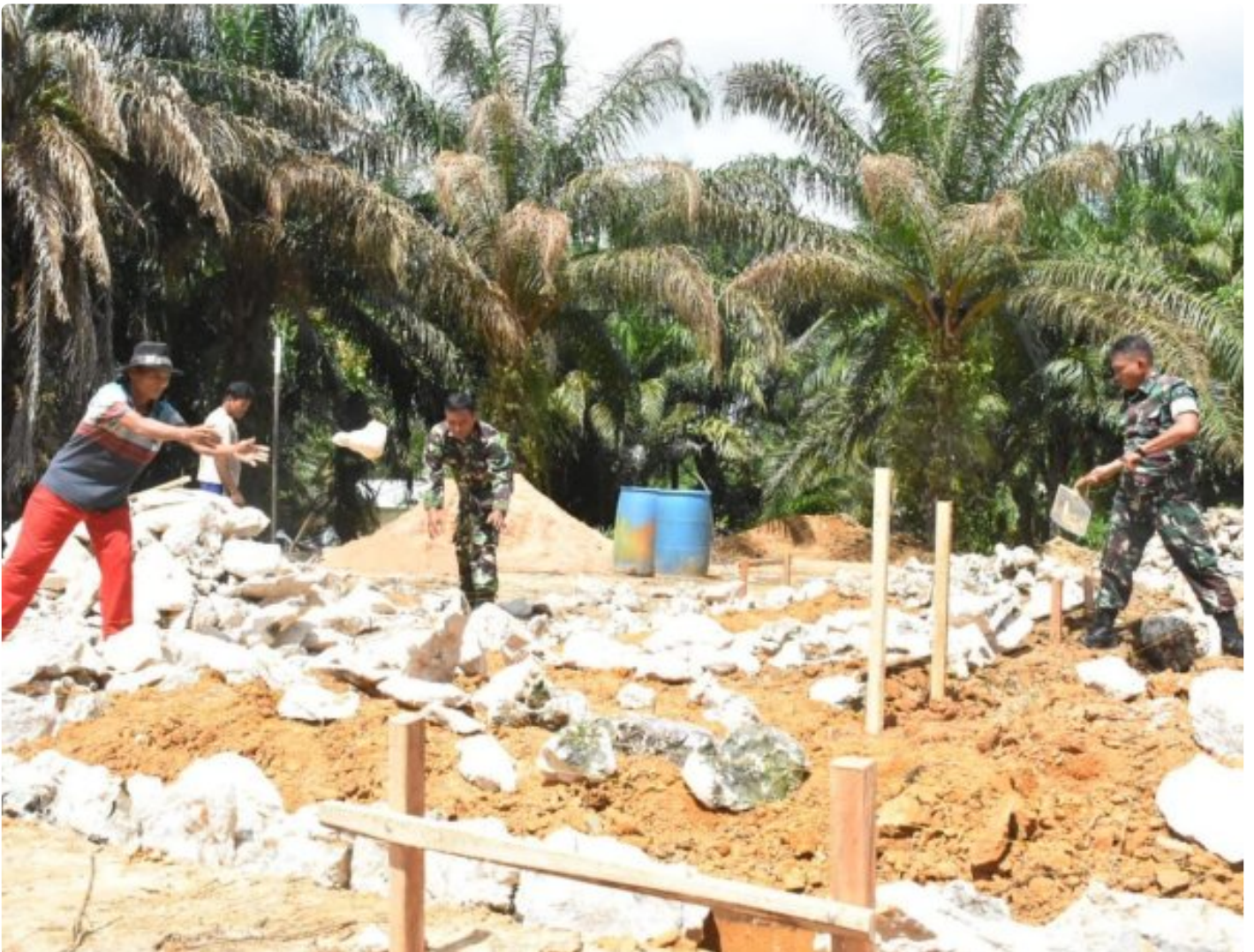
Satgas Pra TMMD Ke 116 Kodim 1004 Kotabaru Mulai Bedah Rumah Mbah Pasih
